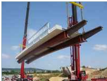
Brücke aus Kunststoff.
