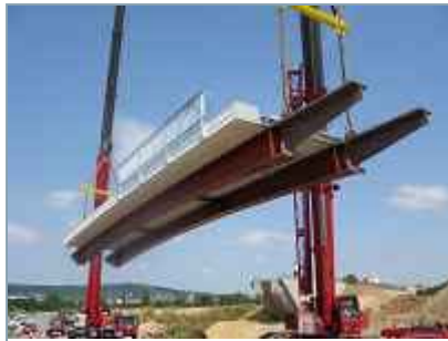
Brücke aus Kunststoff.
