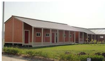
Schnelle Schule: Die Leichtbaukonstruktion aus Verbundwerkstoffen lässt sich binnen weniger Tage aufbauen. Wände, Türen und Innenausstattung bestehen aus glasfaserverstärkten Kunststoffen, das Dach ist eine Stahlkonstruktion
